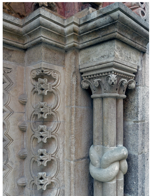
Abb. 14 Fragment, rechtes Portal-Gewände mit verknoteter Säulen-Bündelung
