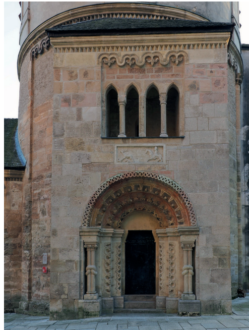
Abb. 3 Risalit mit Portal und Loggia
